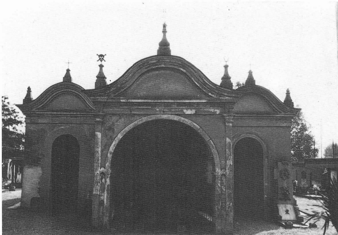
S. Bartolomeo dei Morti - Cappella centrale camposanto
